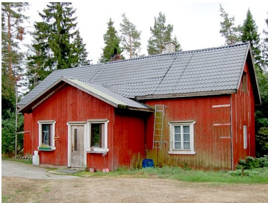
Bostadshuset sett från norr 28.8.2006
