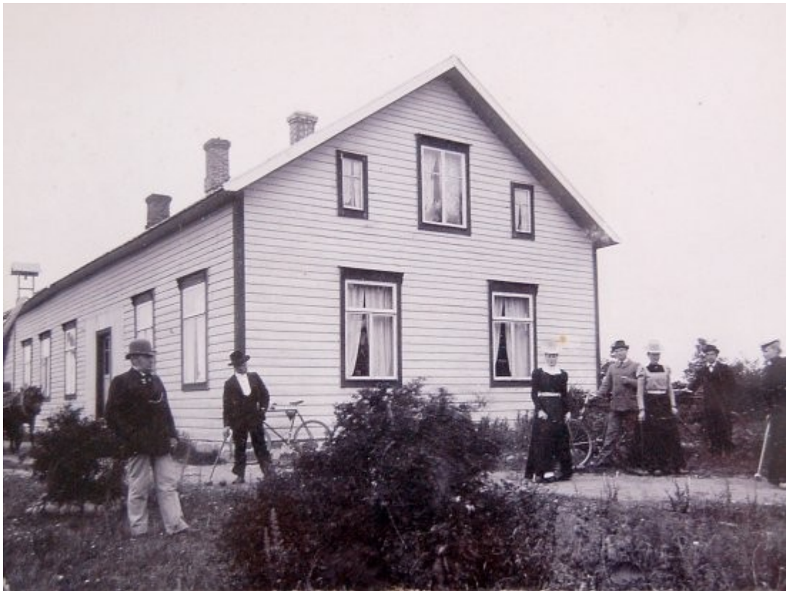
Karaktärshuset sett från söder före det senaste tillbygget
