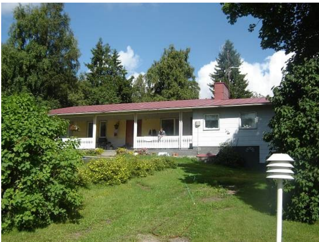
Huvudbyggnaden från sydost 5.8.2005
