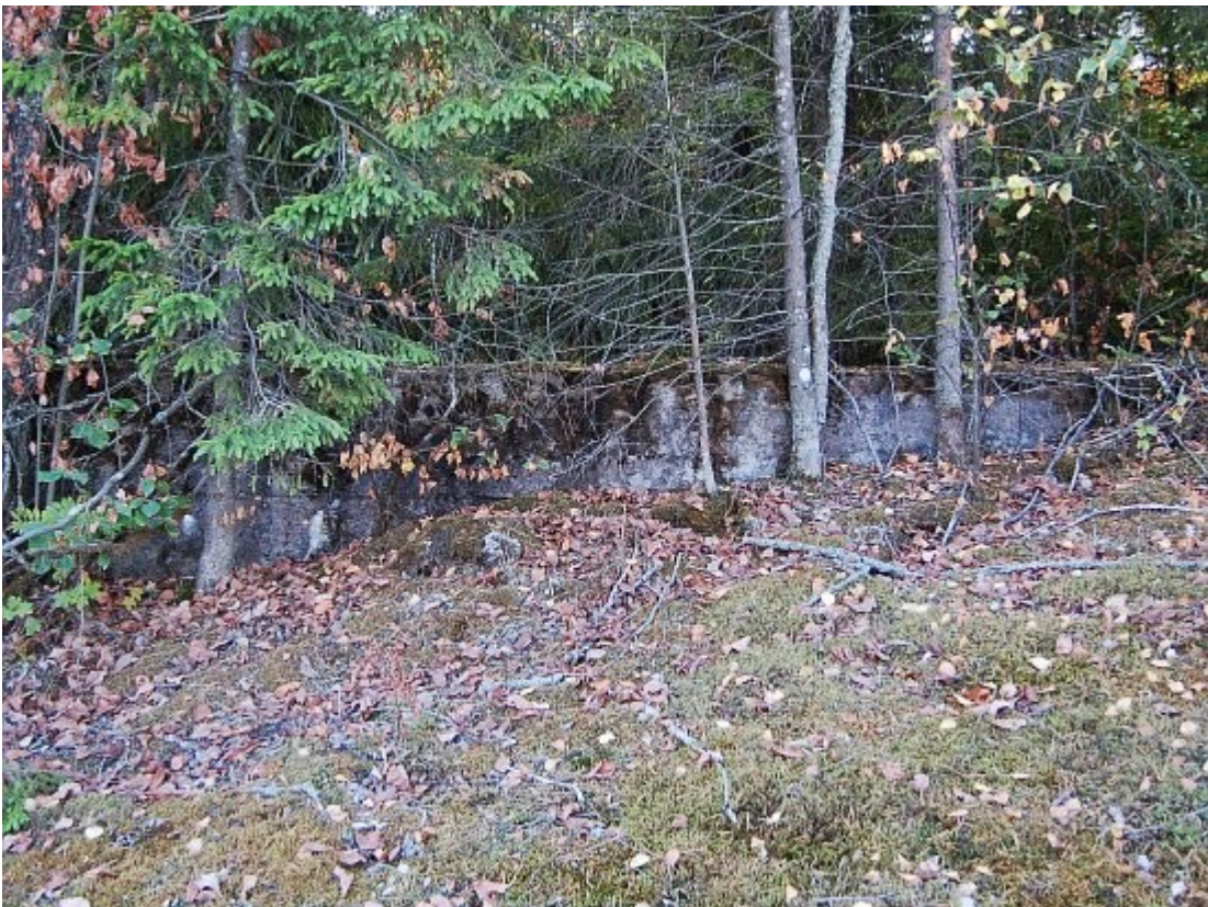
Grunden sedd från norr 21.8.2006
