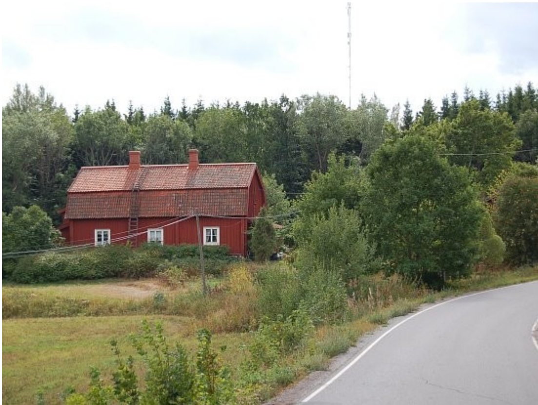
Källbyggningen sedd från norr 16.8.2006
