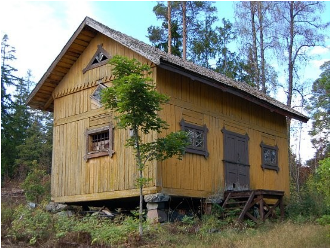
Spannmålsmagasinet sett från öster 29.8.2006
