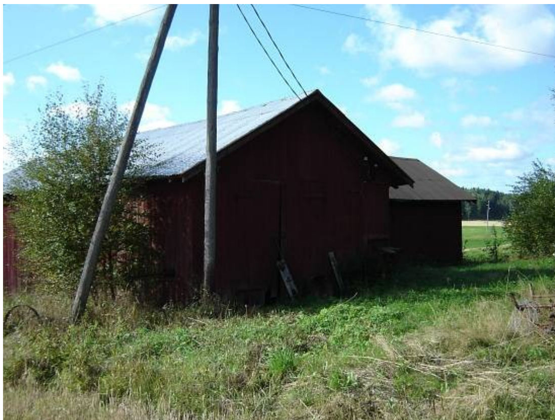
Tröskhuset sett från nordost 30.8.2005
