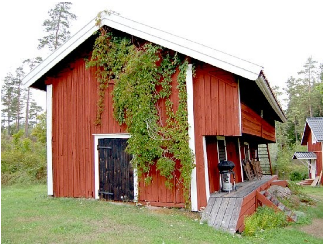
Loftbyggnad sedd från sydost 28.8.2006
