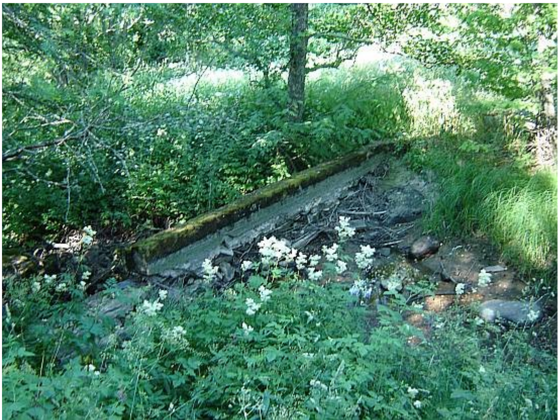
Betongmuren sett från sydost 13.7.2005
