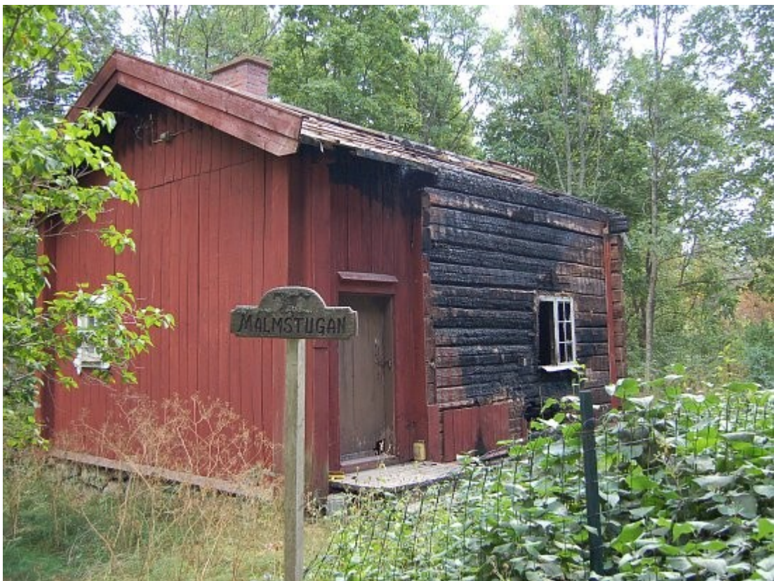
Malmstugan sedd från nordväst 4.8.2006
