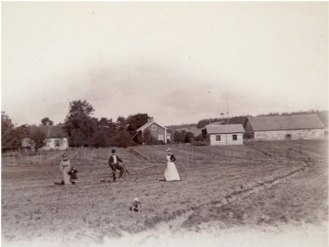
I bakgrunden ser man Nedergård före huset byggdes om
