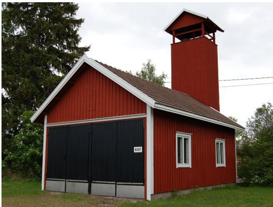
Branddepån sedd från vägen 6.6.2006
